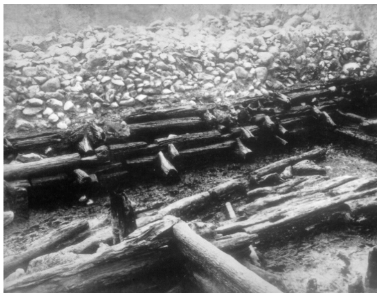
Ryc. 7. a – Fragment wału wykonanego w konstrukcji hakowej z grodu w Gnieźnie; b – fragment wału obronnego grodu w Poznaniu na Ostrowie Tumskim z ławą kamienną w skrzyniach drewnianych umocnionych konstrukcją hakową (zdjęcia archiwalne ze zbiorów Muzeum Archeologicznego w Poznaniu)
