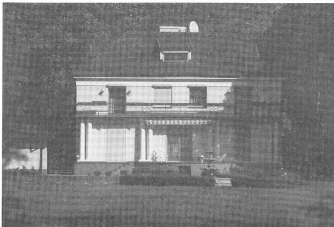
Ryc. 3. Poznań-Strzeszynek. Willa prof. Józefa Kostrzewskiego (rok budowy: 1931). Stan obecny (fot. A. Prinke)
